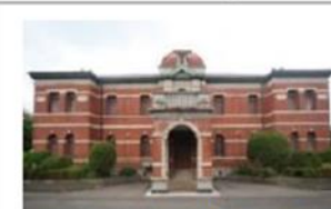
※一般には非公開の施設です 写真提供: 日本製鉄(株)九州製鉄所 世界文化遺産に登録された官営八幡製鐵所旧本事務所
