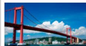
若松と戸畑を結ぶ若戸大橋
